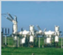
Hoch integrierte Schaltanlagen (HIS) bis 550 kV sparen jede Menge Platz
