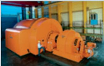
Einer der drei Kurzschlussgeneratoren, die gemeinsam einen Kurzschlussstrom von mehr als 100 kA liefern und zu einer äquivalenten synthetischen Prüfleistung von mehr als 100 GVA beitragen
