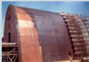
1959: Errichtung der Parabelhalle mit ihrem Kupferdach, das gegen elektromagnetische Störungen abschirmt
