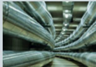
Gasisolierte Leitungen (GIL) sind eine technisch überzeugende und kostengünstige Alternative zu Kabeln und Freileitungen
